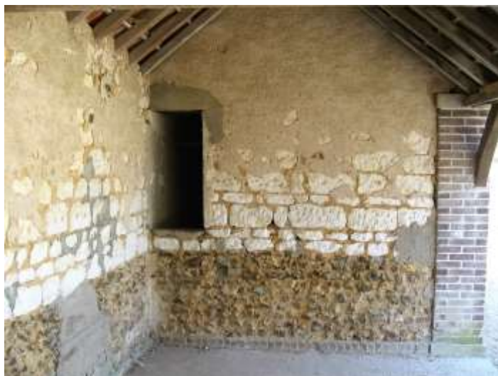
Préau de l'école avant travaux
