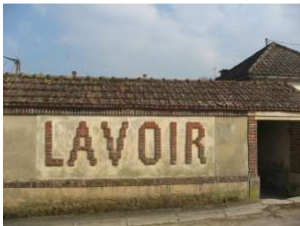
Le lavoir avant travaux
