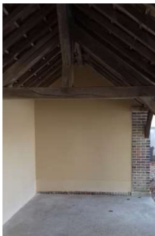
Préau de l'école après travaux
