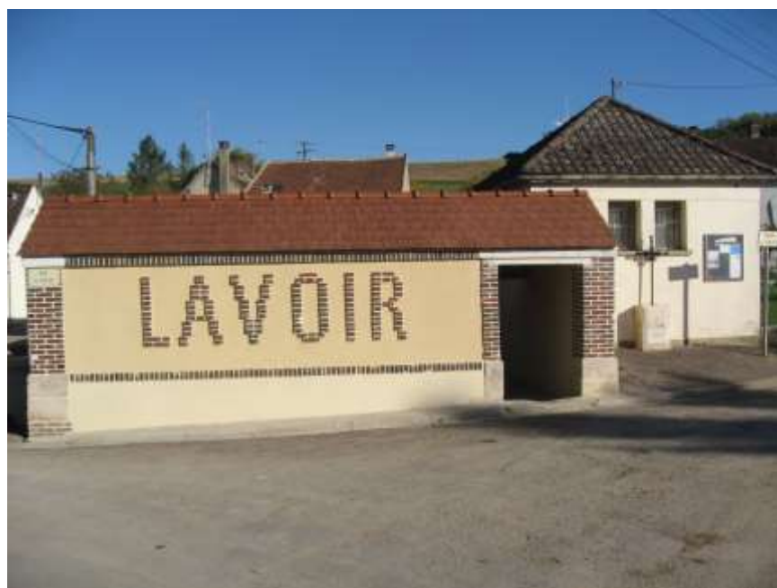
le lavoir après travaux
